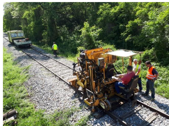
Die Stopfmaschine im Einsatz
